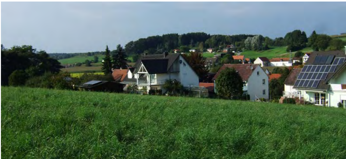
Abb. 7: Blick auf die nördlich an das geplante Baugebiet angrenzende Wohnbebauung
