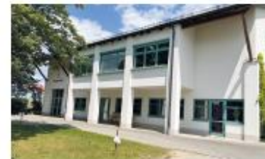
Stotzard Gemeinschaftshaus Hausener Straße 12, 86447 Aindling
